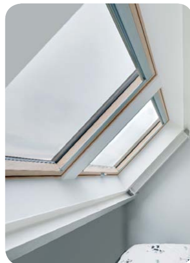
Maison passive à Sint-Pieters-Leeuw, construite en 2013, fenêtres de toit FAKRO superisolantes FTT U6.
