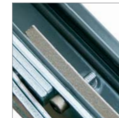
Le système de protection contre le démontage du double vitrage
